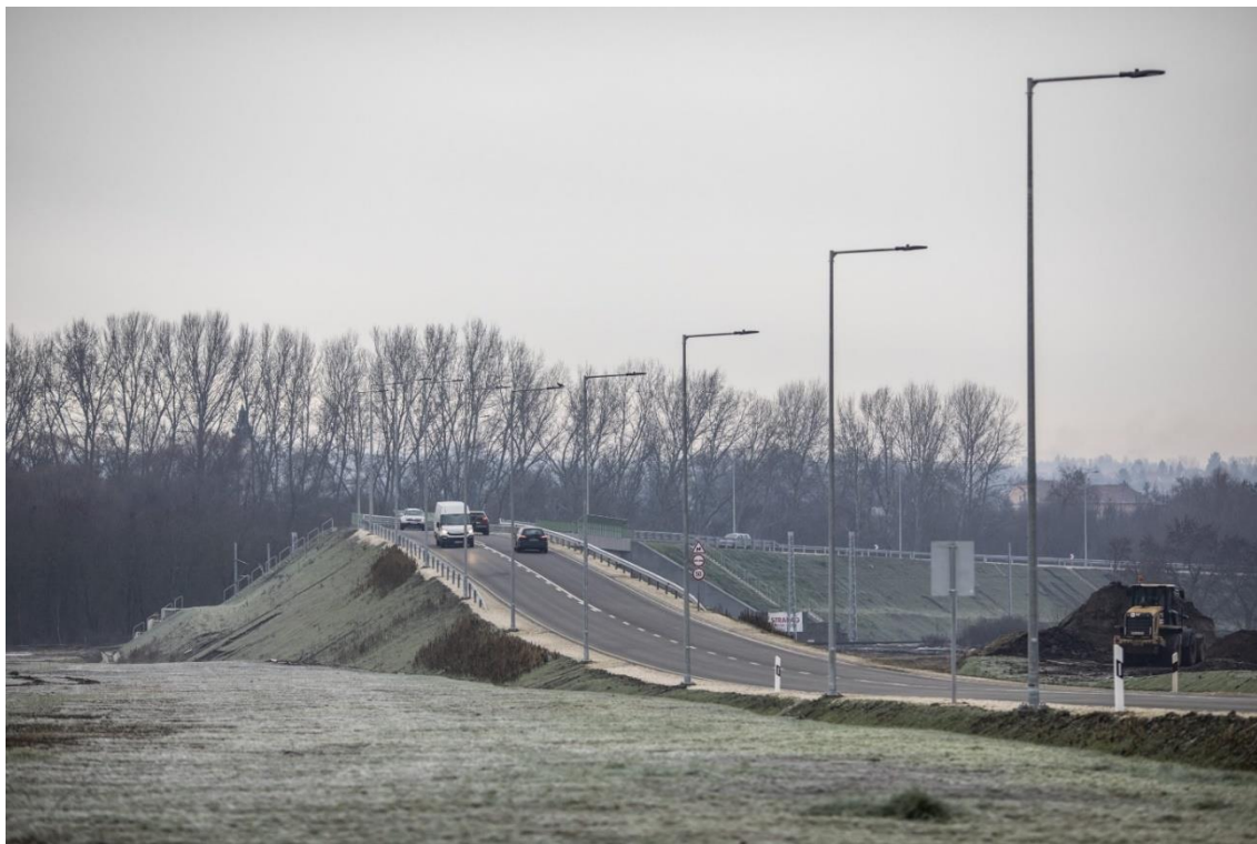
19. ábra Tarcsai úti felüljáró. Kép: NIF Zrt.
